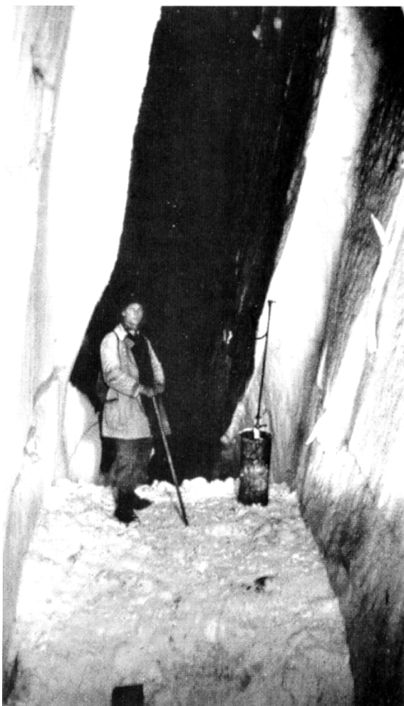
Fig. 2: Simple digging tools for the construction of ice galleries./ Einfache Grabwerkzeuge zur Errichtung der Eisstollen. / (ANGETTER 2009).
