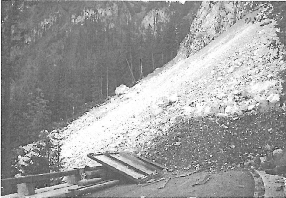
Abb. 6 Überschüttete B308 von Osten. Gute Sortierung erkennbar.
