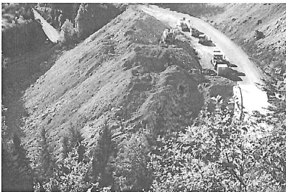
Abb. 7 Freigelegte und reparierte B308 im August 2000.
