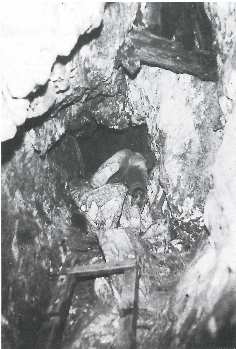
Foto 2 Verhau, Aufnahmestandpunkt bei P 17, Blick in Richtung P 22 und P 26 (Kamera etwa 40° nach oben gerichtet, vgl. dazu Profil 11–12 auf Abb. 6). Unterer Bildteil: Versatz und (überlagerndes) Versturzmateriale, davor Reste einer „neuen“ Leiter als Aufstiegshilfe. Bildmitte: Durchfahrt von P 22 auf P 26 hinauf mit Person als Größenvergleich. Darüber Bergfeste. Am Bildoberrand eine „Bühne“, oberhalb der Versatzmaterial ansteht.
