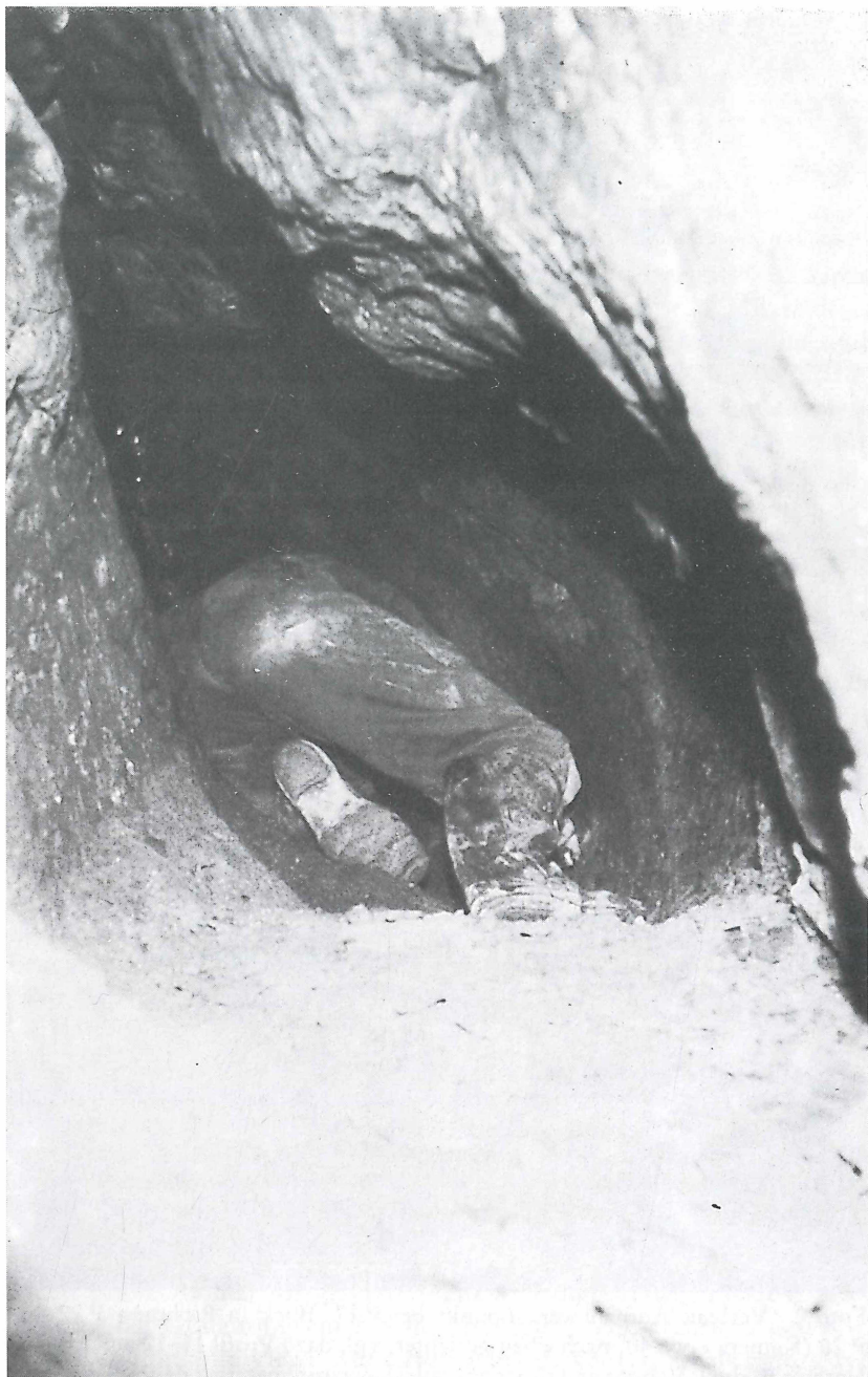
Foto 1 Die „Verbindungsstrecke“, von P 10 in Richtung P 15 gesehen (vgl. Abb. 4). An der Firste erkennbar der ausgebrochene Kernbereich des Mylonits der Scherfläche (vgl. dazu auch Profil 7–8 auf Abb. 5).
