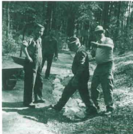
Sanierung von Gerinnen, Bild-Mitte: Bezirksleiter Gottfried Ritz.
