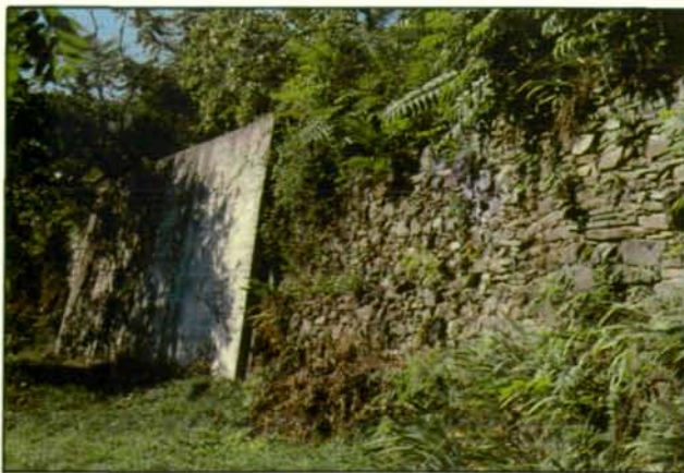
Abb. 4: Unmittelbar nebeneinander: skorpionfeindliche Betonmauer und -freundliche Legemauer in Krems a. d. Donau.
